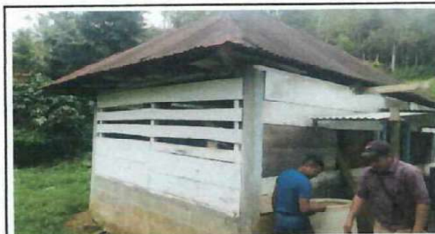
Foto 6: Cambio de techo de cocina
