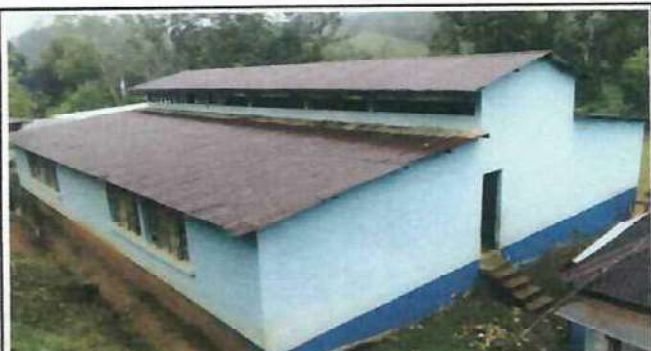
Foto 3: Reparación de pared 15.6 x 5.5 metros
